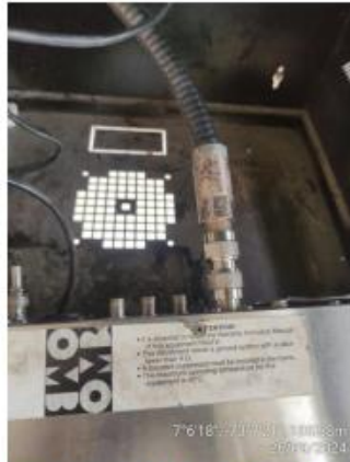
Figura-5 Instalación y reemplazo de transición N-N en TX – Radioenlace MW
