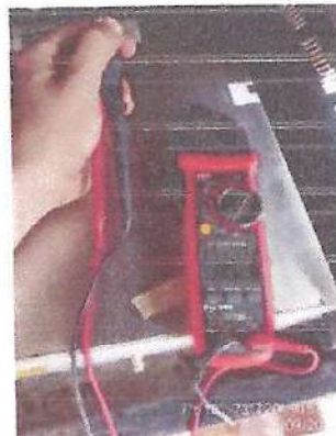
Figura-5 Medición Voltaje AC - Radioenlace MW
